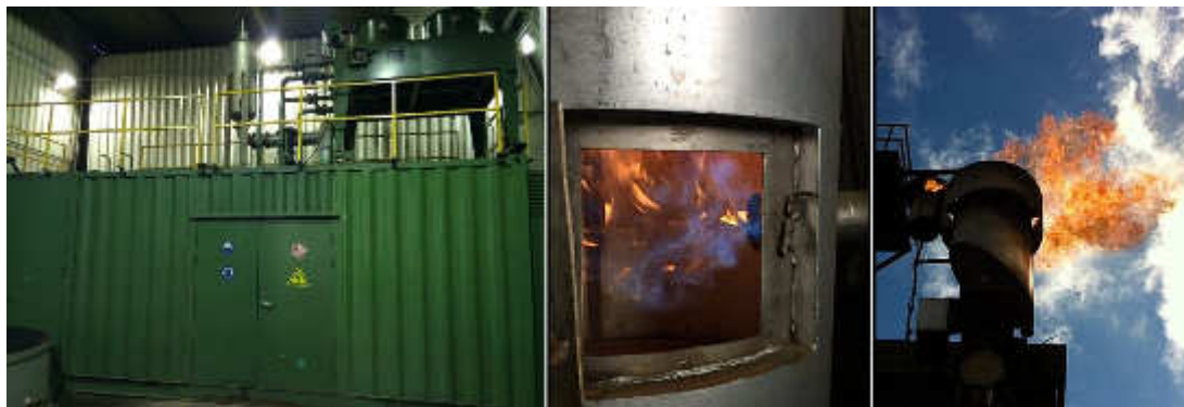
Figura 28 – Moto gerador 180 kW, Fornalha e “Flare”.
